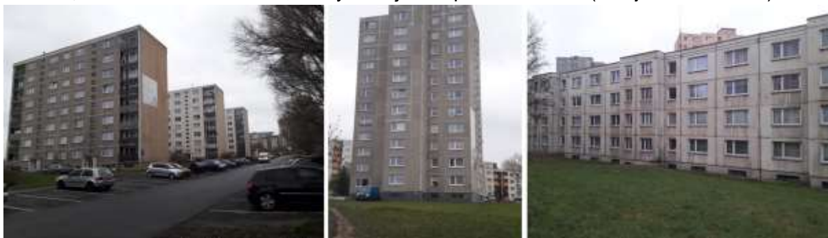
Foto 18, 19 a 20: Sídliště Sever, domy v majetku společnosti CPI (zdroj: archiv autora)
