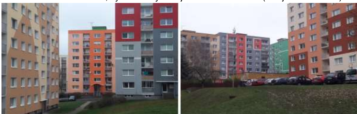
Foto 21 a 22: Sídliště Lada, bytové domy v majetku SVJ a družstev (zdroj: archiv autora)
