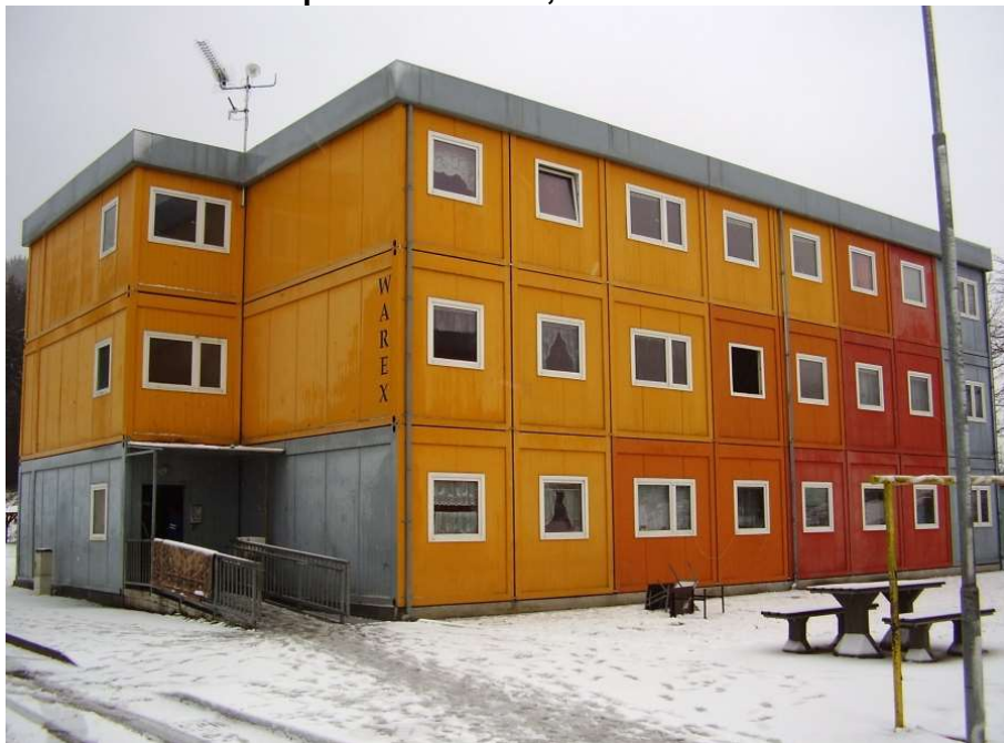
Obrázek 3 – dům č.p. 2083 Poschla, Vsetín
