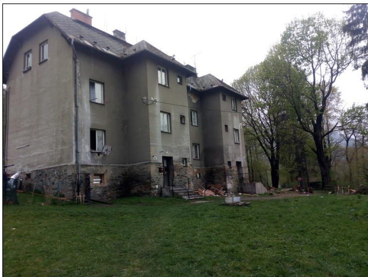
Obrázek 5 objekt v ulici Palackého č.p. 288 a 289 (zdroj: archiv autora, duben 2019)
