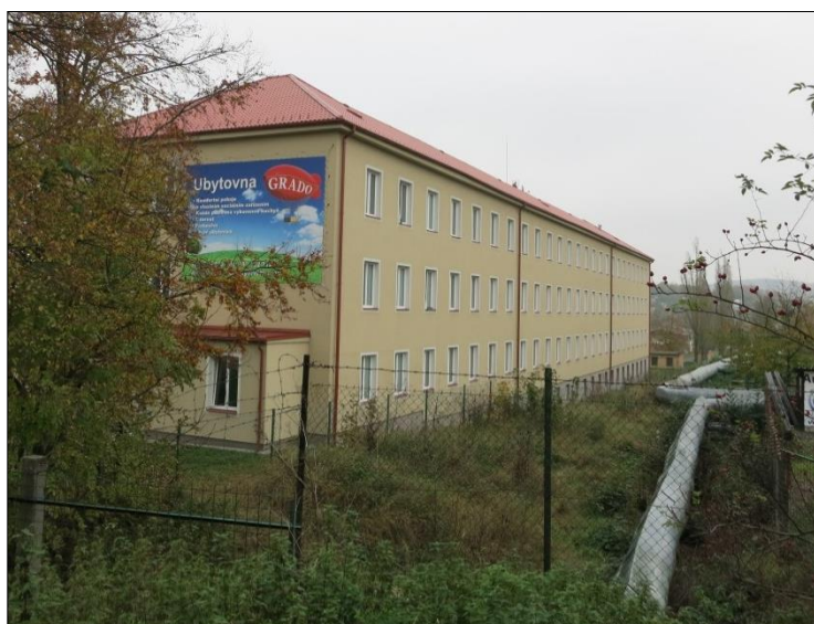
Fotografie č. 11: Ubytovna V Lukách
