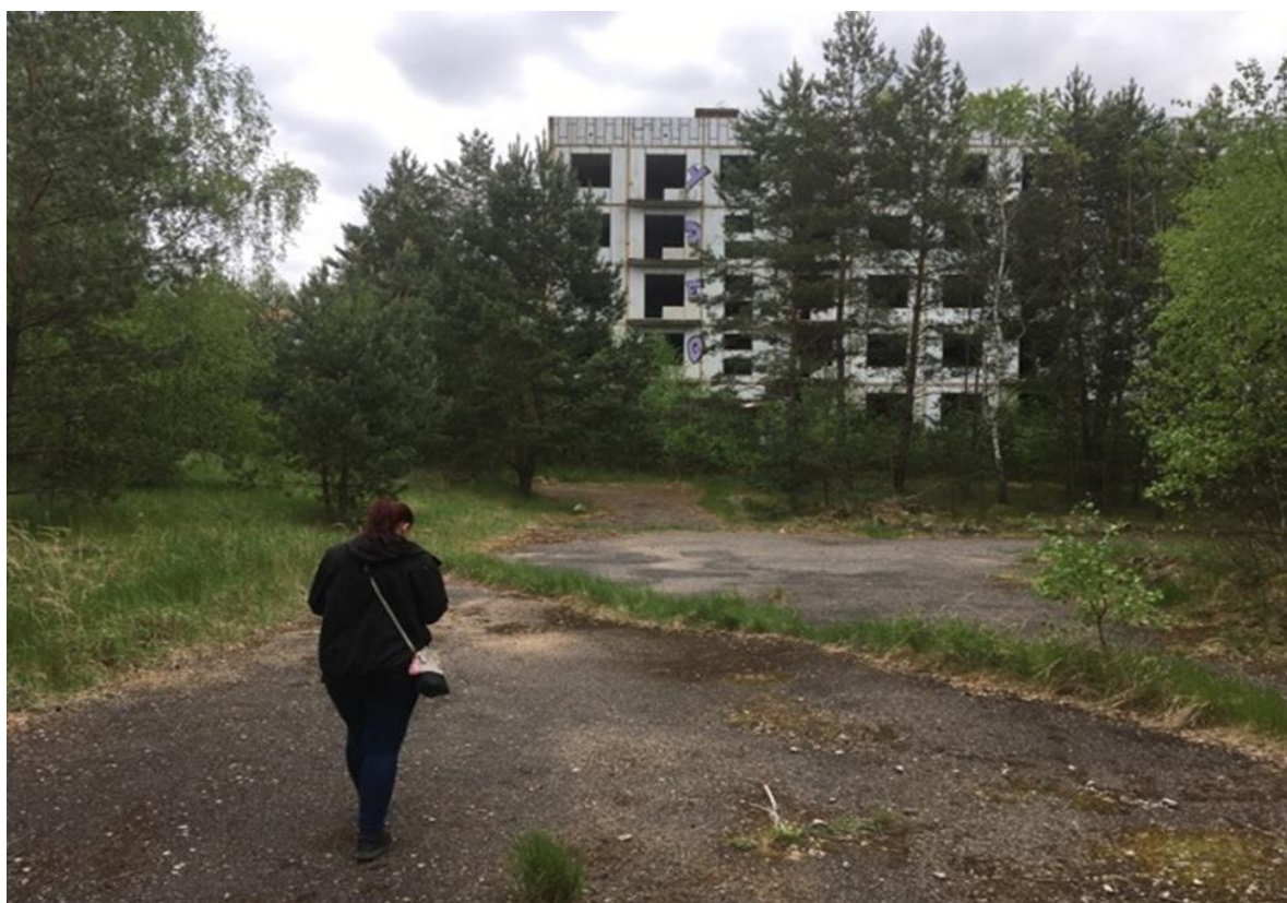
Foto 6 – Neobydlené panelové domy v Ploužnici
