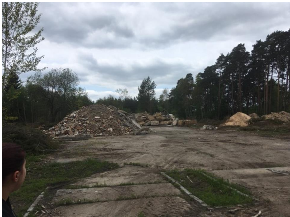
Foto 8 – Sut' z chátrajících panelových domů na okraji Ploužnice
