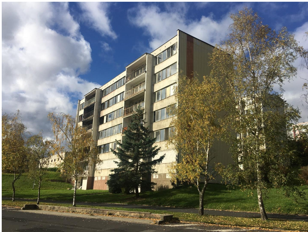
Blok F1, Sadová 283-284, listopad 2023. Zdroj: archiv autorů.
