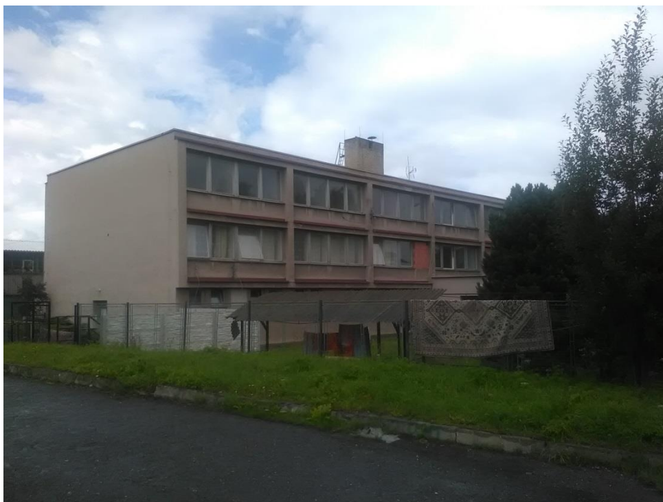
Obrázek 3 - Ubytovna firma FAULHAMMER, jejíž přízemí si pronajímá Polička jako městskou ubytovnu (foto: Martin Šmoldas)
