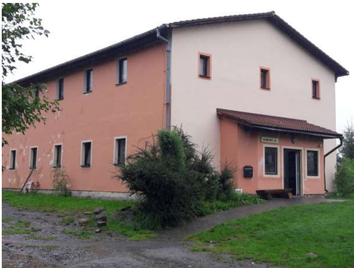
Obrázek 4 - Objekt 353, již s cedulí „nájemní dům“ - současný stav (foto vlastní – září 2020)
