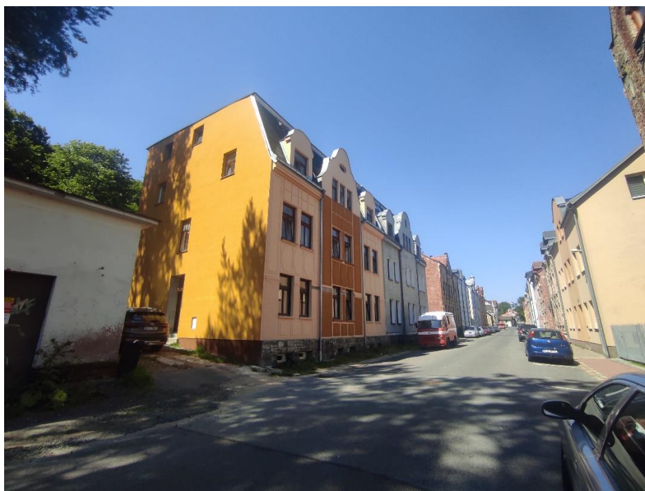
Obrázek 6 Saskova 21, zdroj: autor analytického podkladu (stav srpen 2023)
