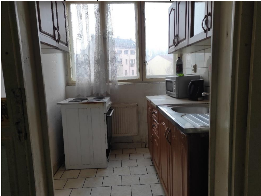
Obrázek 54 Objekt AF (stav březen 2024)
