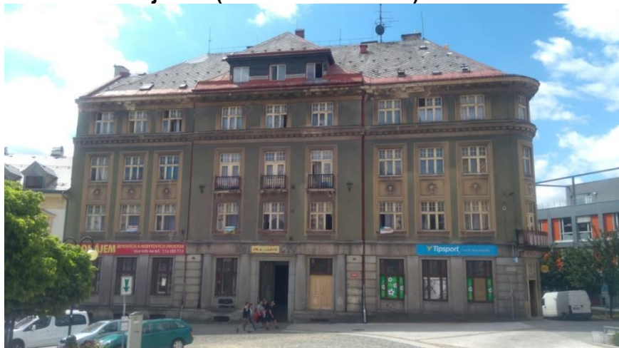
Obrázek 29 Objekt O (stav červenec 2019)
