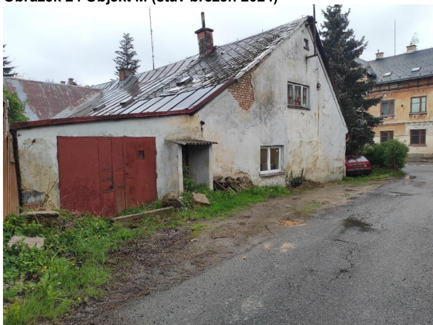
Obrázek 24 Objekt M (stav březen 2024)
