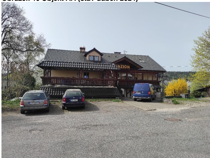
Obrázek 46 Objekt AA (stav duben 2024)
