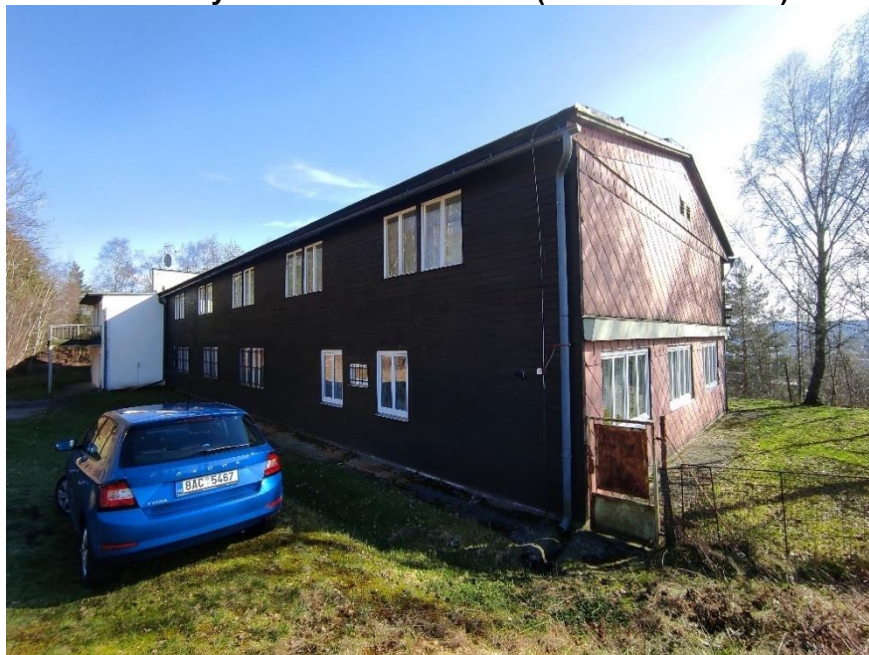
Obrázek 70 Ubytovna v ulici Sněhová (stav březen 2024)
