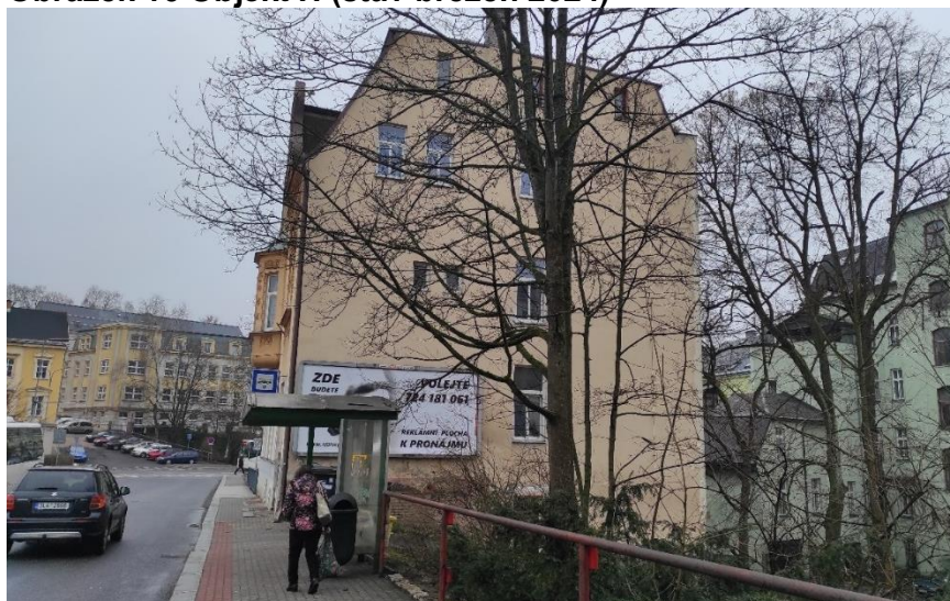
Obrázek 16 Objekt H (stav březen 2024)
