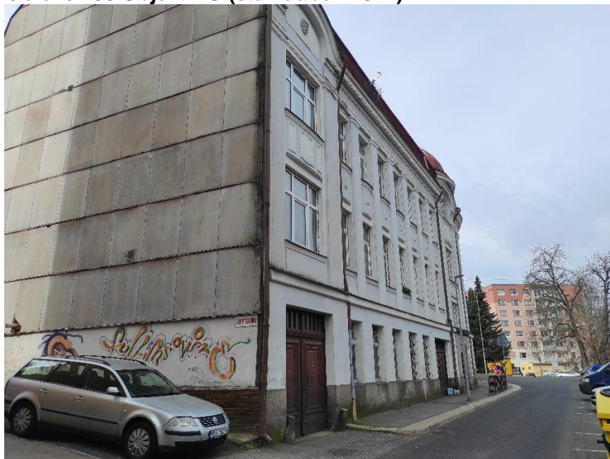
Obrázek 58 Objekt AG (stav duben 2024)
