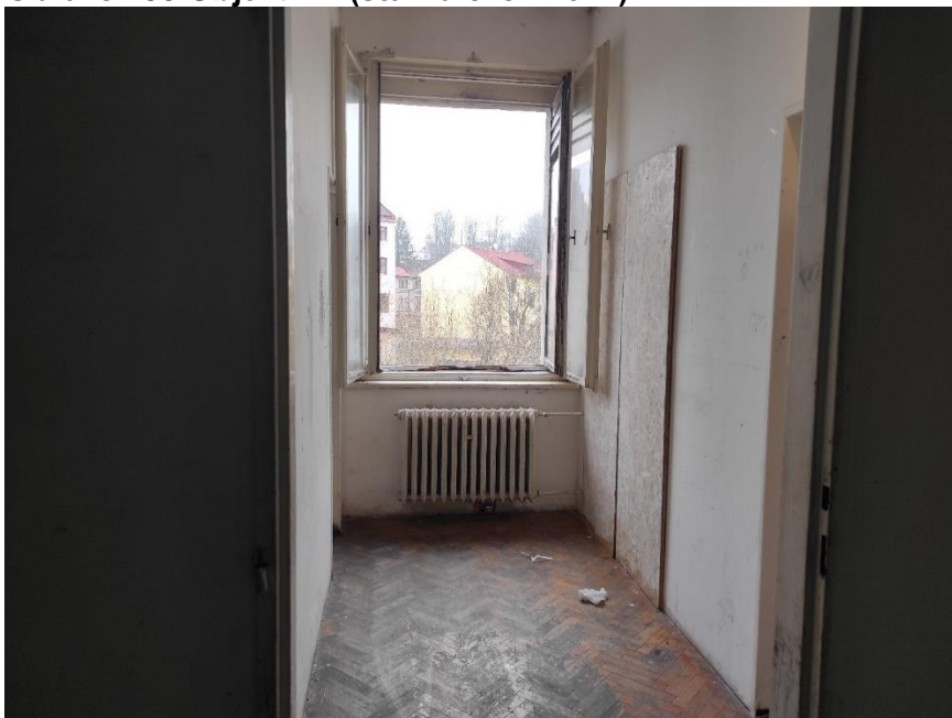
Obrázek 55 Objekt AF (stav březen 2024)
