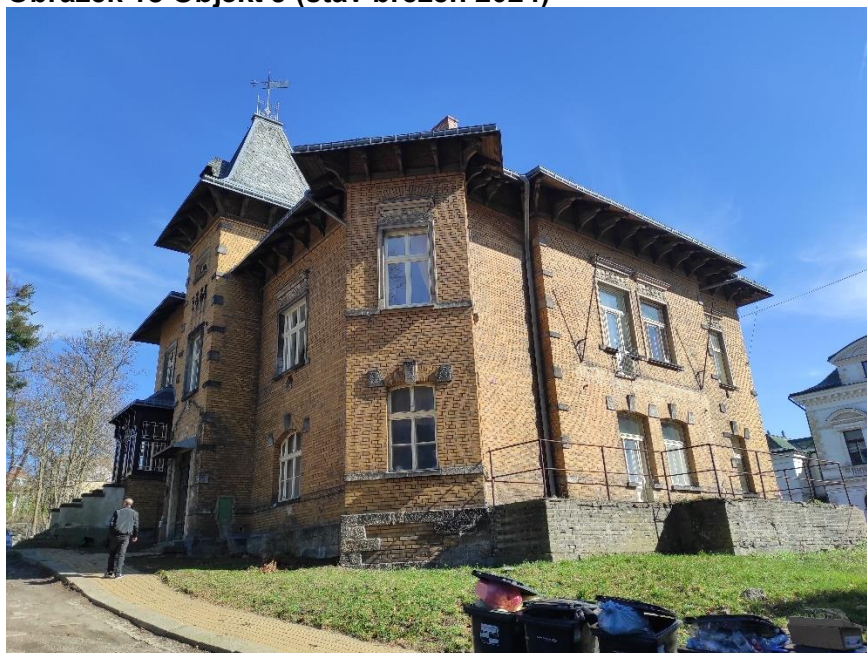
Obrázek 18 Objekt J (stav březen 2024)
