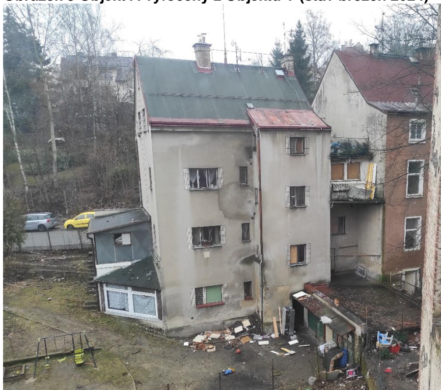
Obrázek 5 Objekt A vyfocený z Objektu Y (stav březen 2024)
