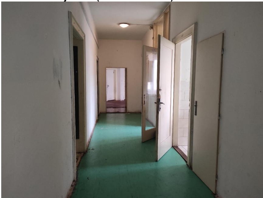
Obrázek 56 Objekt AF (stav březen 2024)
