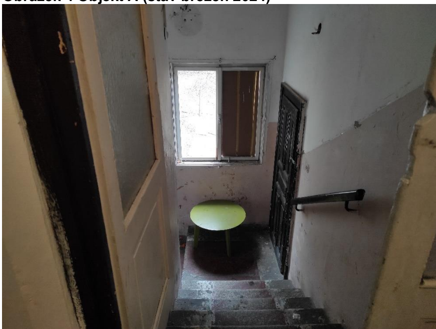
Obrázek 4 Objekt A (stav březen 2024)
