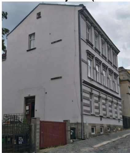
Obrázek 38 Objekt T (stav červenec 2019)
