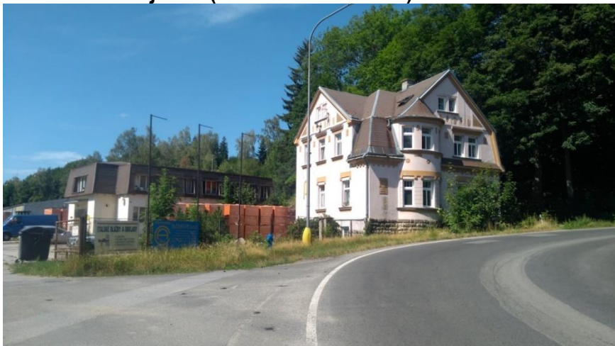
Obrázek 22 Objekt L (stav červenec 2019)
