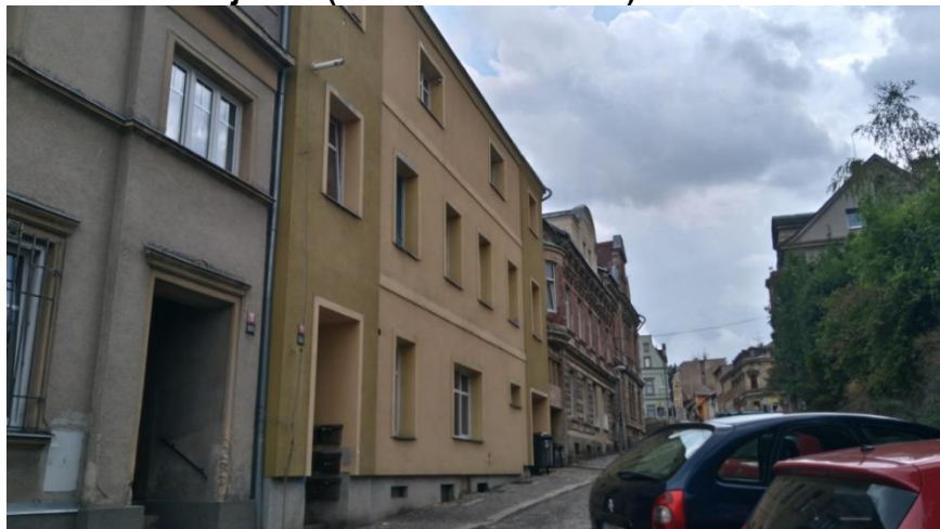
Obrázek 39 Objekt U (stav červenec 2019)
