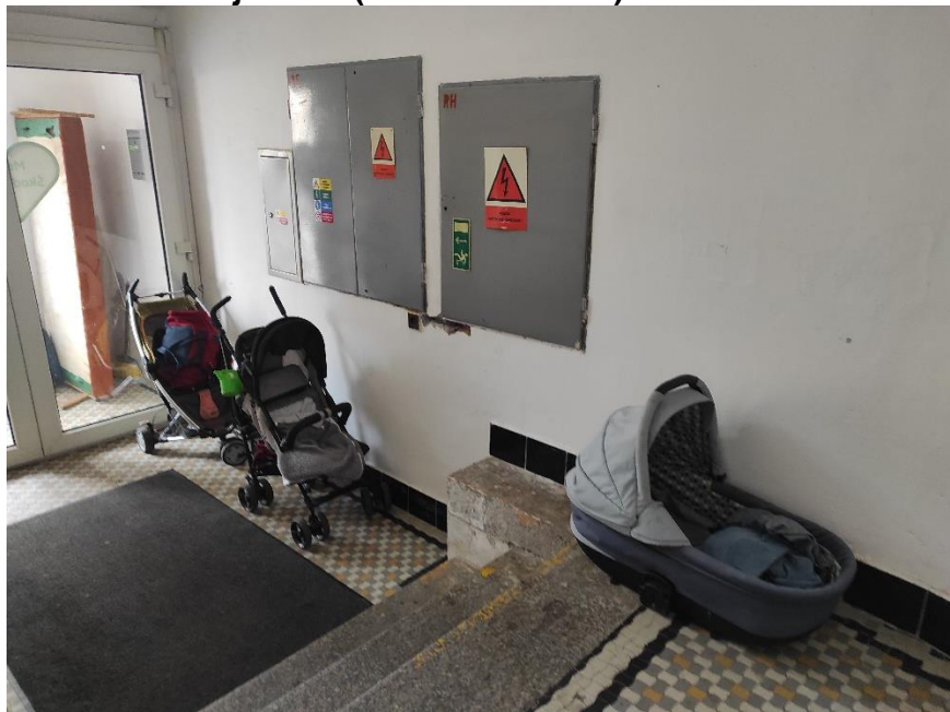
Obrázek 61 Objekt AG (stav duben 2024)
