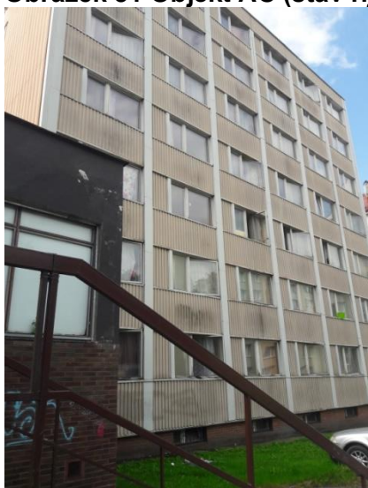
Obrázek 51 Objekt AC (stav říjen 2019)
