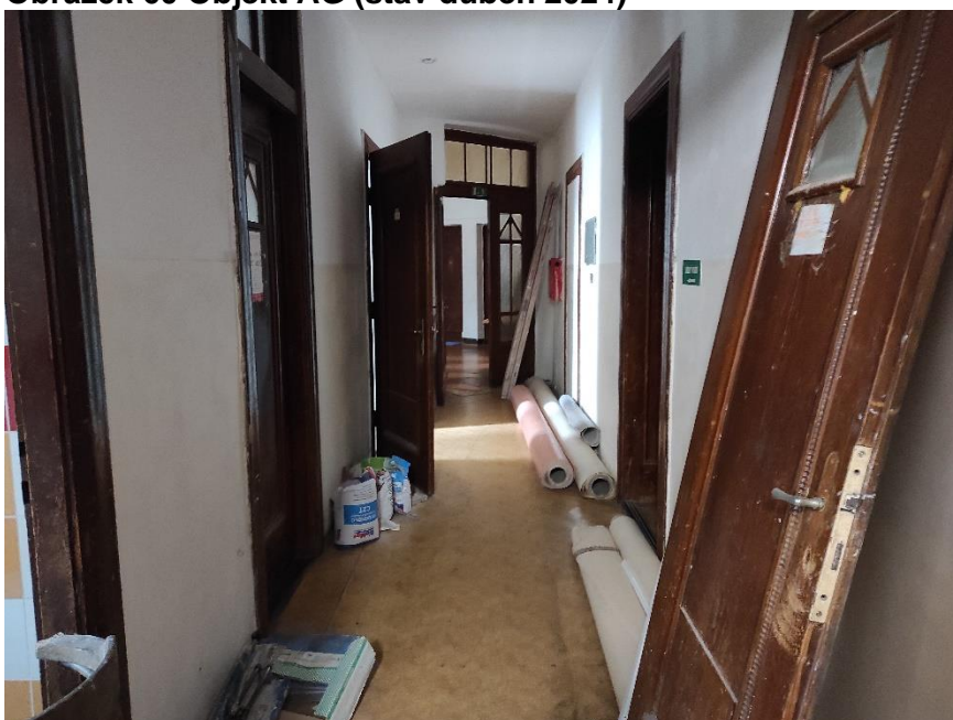
Obrázek 60 Objekt AG (stav duben 2024)
