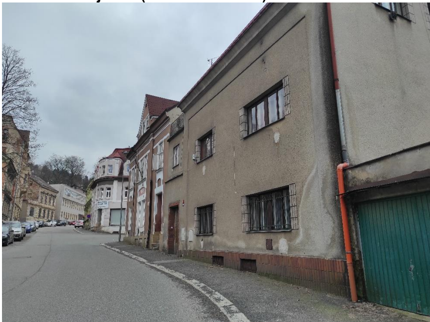
Obrázek 3 Objekt A (stav březen 2024)
