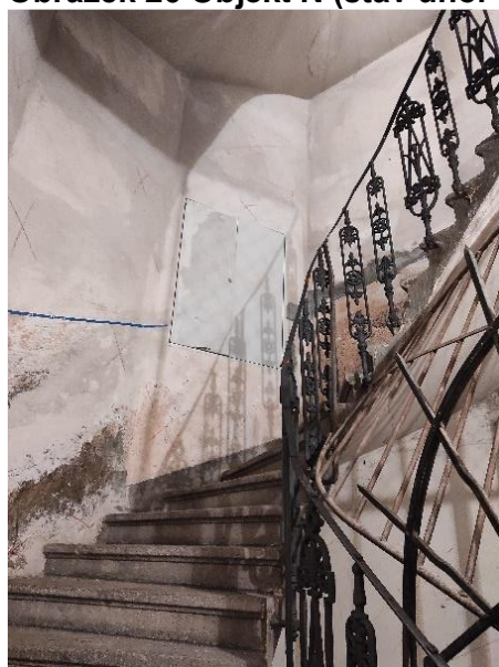
Obrázek 26 Objekt N (stav únor 2024)
