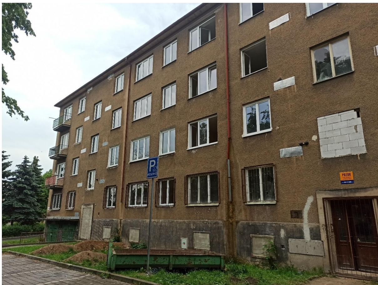
Obrázek 8: Prázdný dům, v čase výzkumu v rekonstrukci
