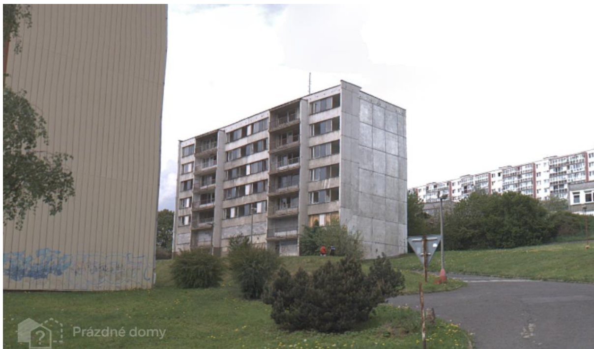
Obr. 7: Blok F3, zde v roce 2015, stojí v nezměněném stavu již 10, spíše však 20 let. Zdroj: Prázdné domy.
