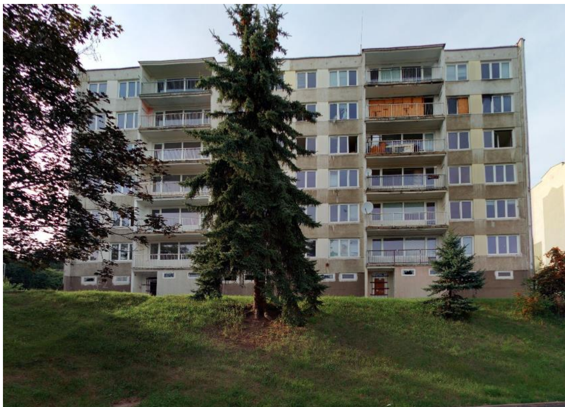
Obr. 6: Rok 2021, dům F2 opuštěn, vchody jsou zamřížované. Zdroj: mapy.cz.
